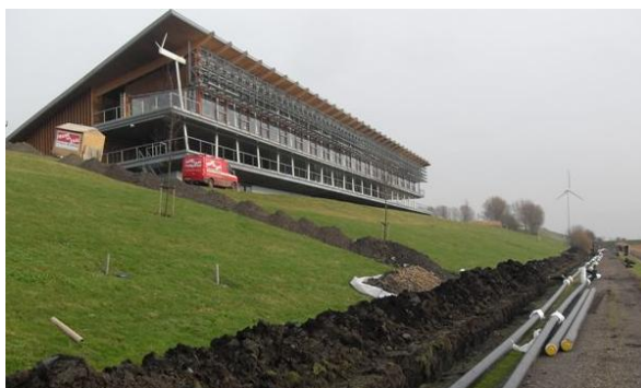
Bromeliaverdelaar Corn. Bak gebruikt een 3 km lange transportleiding om haar kassen te verwarmen met water, dat verhit wordt door het verbranden van vrijkomend gas uit de naastgelegen vuilnisbelt
